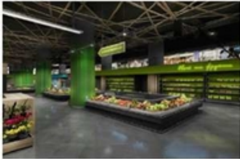
- Супермаркет «Сільпо», ТРЦ Gulliver, м.Київ Проектування та монтаж інженерних мереж
