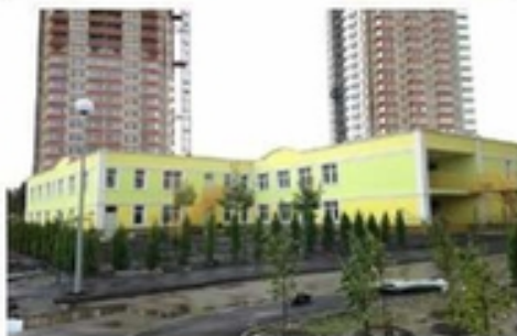
- Житловий комплекс «Паркові озера», дитячий садок, м.Київ. Монтаж інженерних систем ОВ, ВК, ГП, ЕО, Автоматизації
